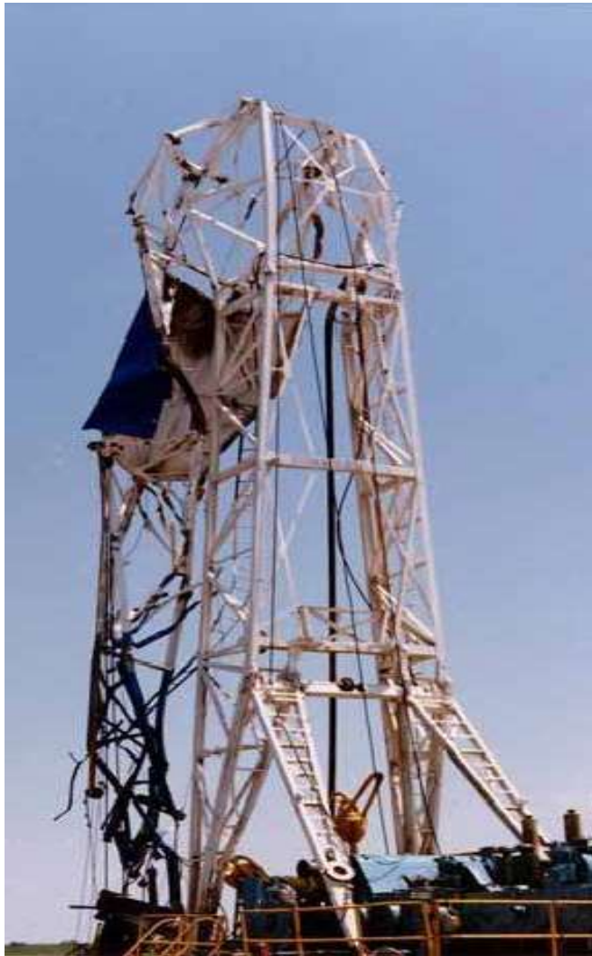
Défaillance du mât d'appareil de forage en raison de la corrosion
