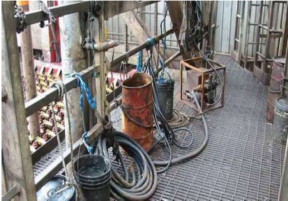
Mauvais entretien gestion sur la plate-forme d'accrochage
