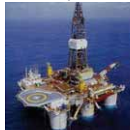
Plateforme de forage semi-submersible
